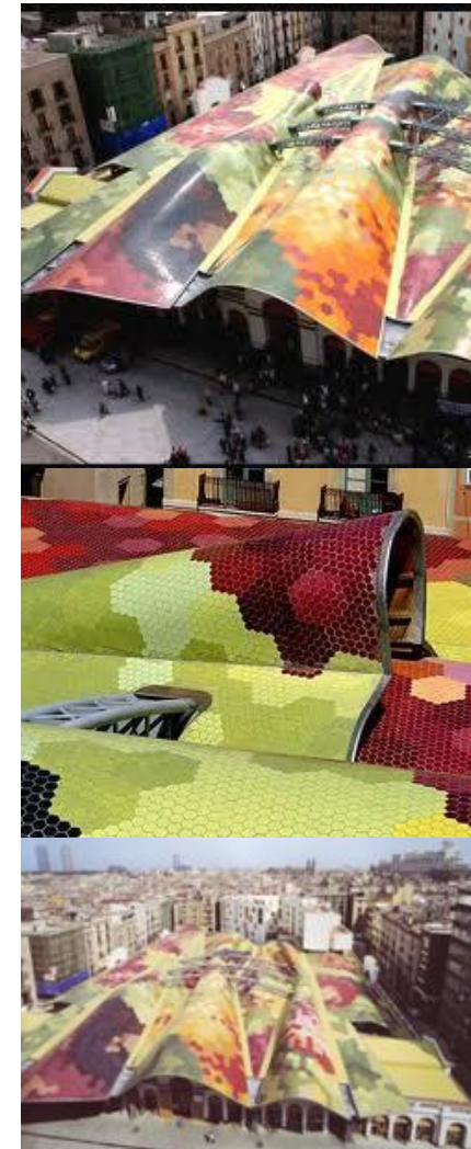
Restaurering af Santa Caterina Markedet, Barcelona
